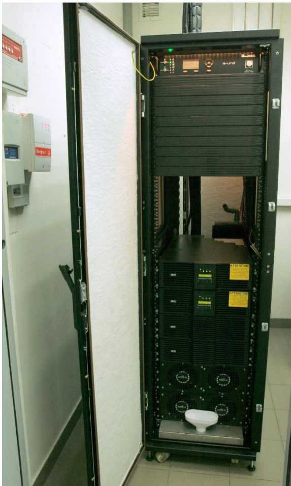
Размещение кондиционеров внутри 19-дюймовой стойки.
