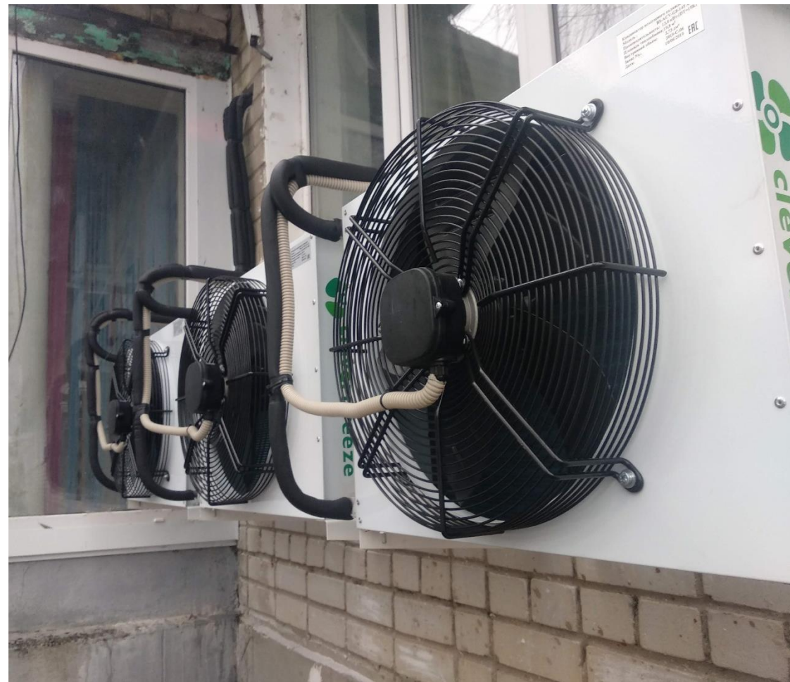
Внешние блоки кондиционеров Clever Breeze
