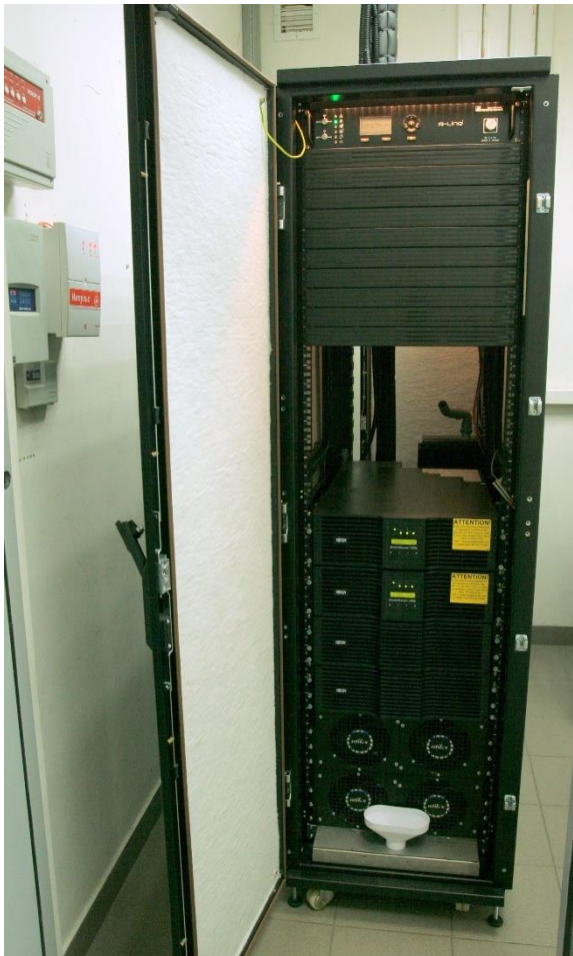
Размещение кондиционеров внутри 19-дюймовой стойки.
