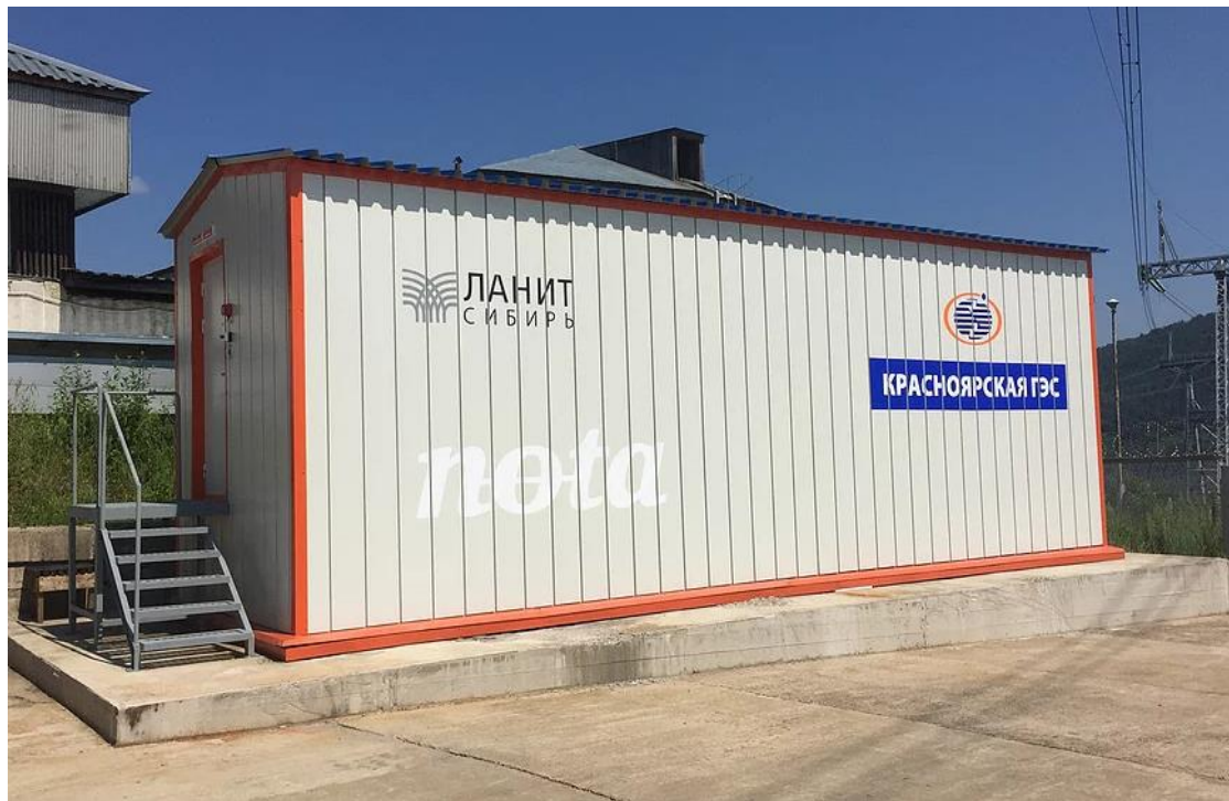
МЦОД для Красноярской ГЭС
