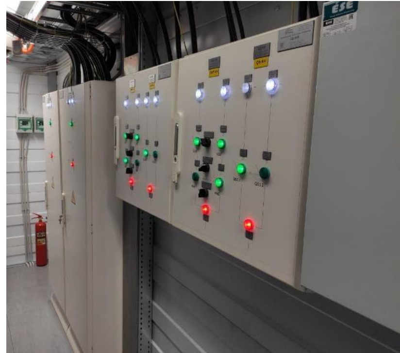
Система ввода и распределения питания в МЦОД
