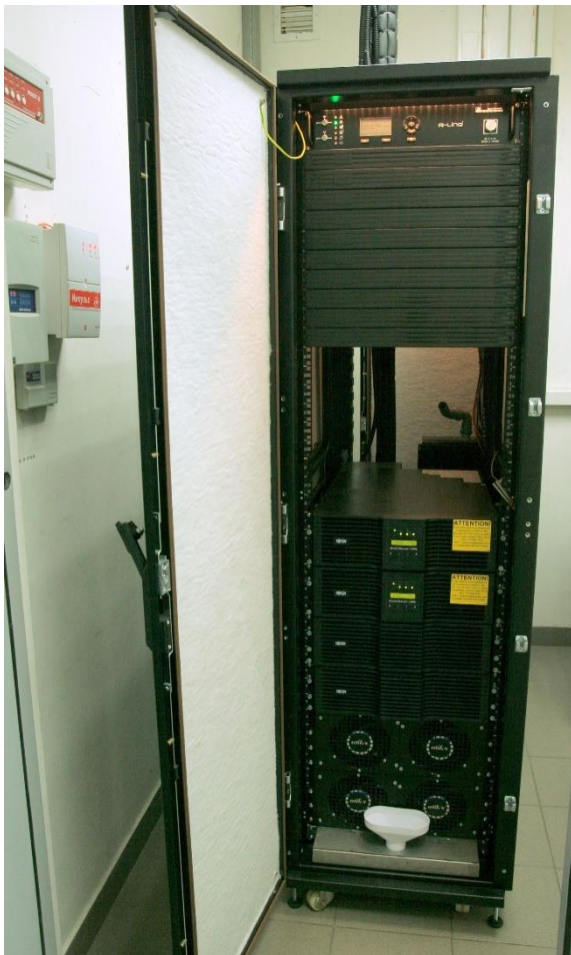
Размещение кондиционеров внутри 19-дюймовой стойки.
